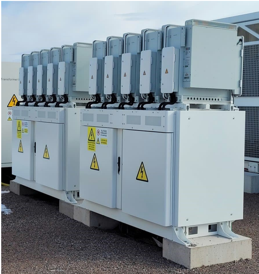
Figur 6. Exempel på stativ med växelriktare.
